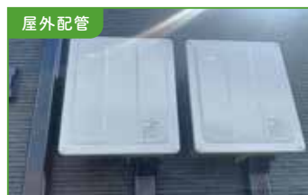
屋外配管 パワーコンディショナへの配管・配線が外壁材の外側を通ります。
